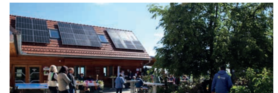
Die neue Photovoltaik-Anlage in Labuch.
